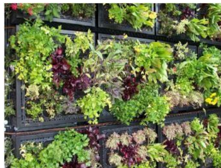
5 pav. Modulinė gyvoji siena iš blokelių: (Green wall systems: a review of their characteristics, 2014)
